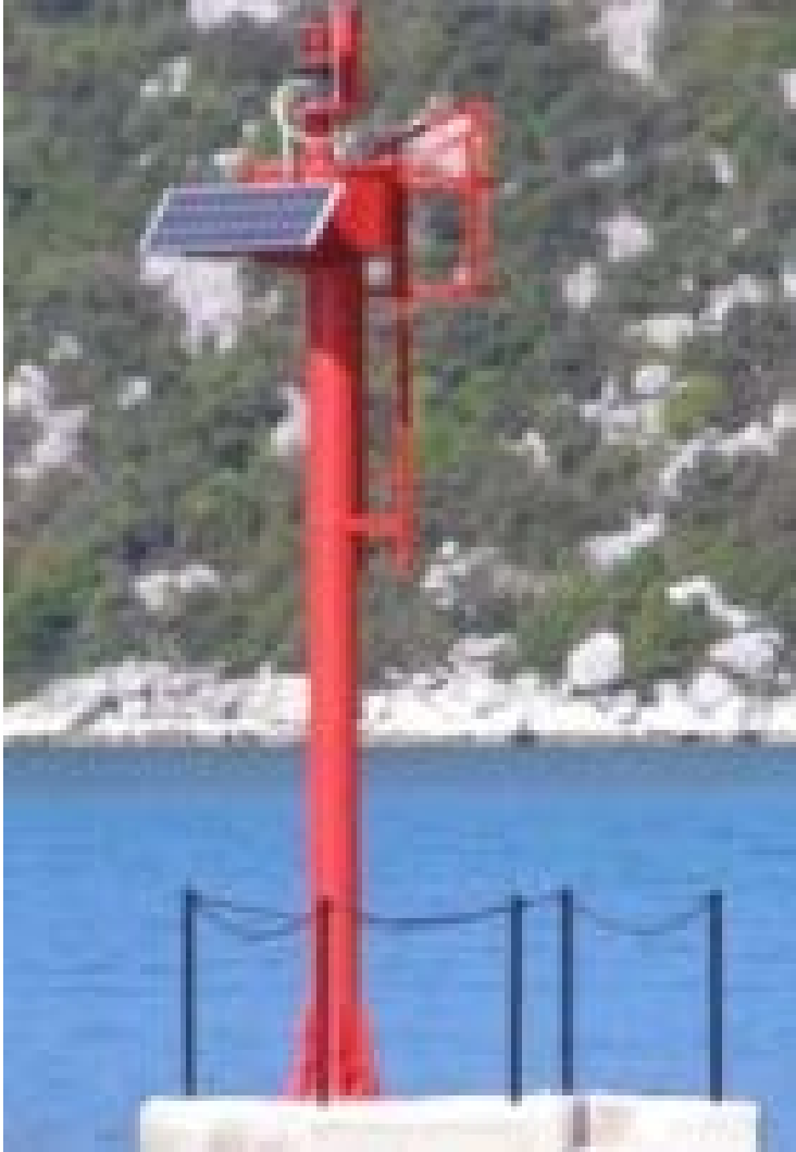
Slika 32. Signalni stup sa solarnim panelom
