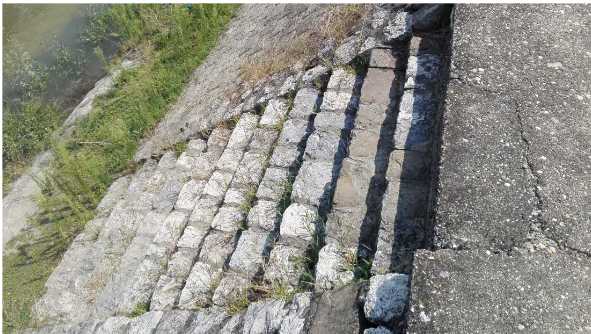
Slika 2-3: Postojeća obaloutvrda gradskog tipa
