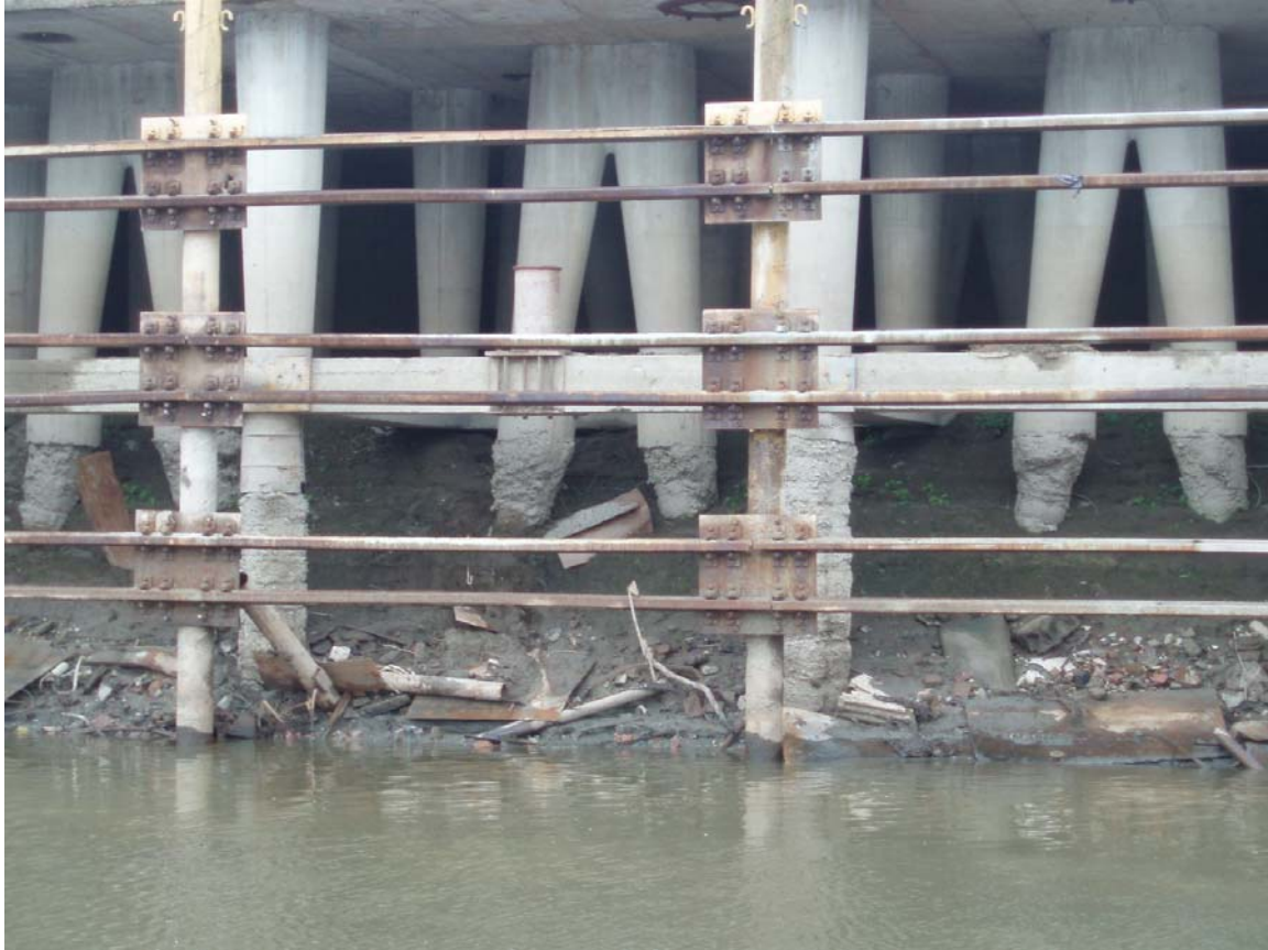
Slika 2.2: Konstrukcija vertikalne obale u Luci Osijek
